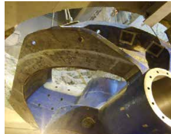
Actual Installation of the Crusher
